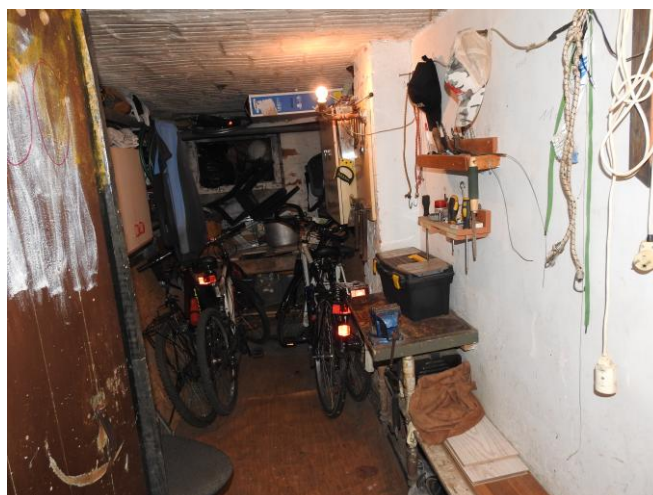
Fot. 22. Piwnica w analizowanym budynku wykorzystywana jako magazyn.
