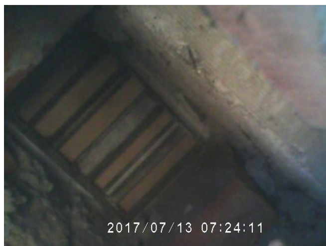
Fot. 19. Szczeliny w elewacji sprawdzone za pomocą endoskopu -brak śladów bytowania ptaków i nietoperzy.
