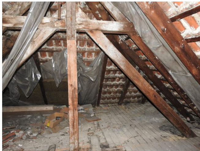
Fot. 20. Strych w analizowanym budynku.
