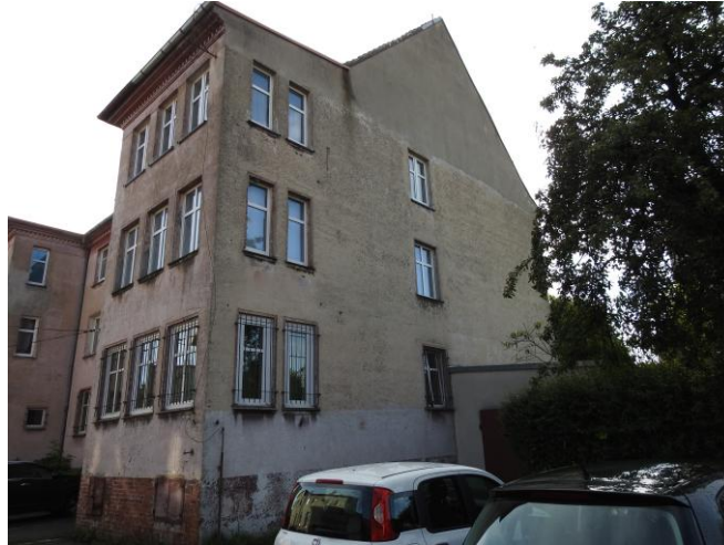
Fot. 4. Elewacja południowo-zachodnia analizowanego budynku.
