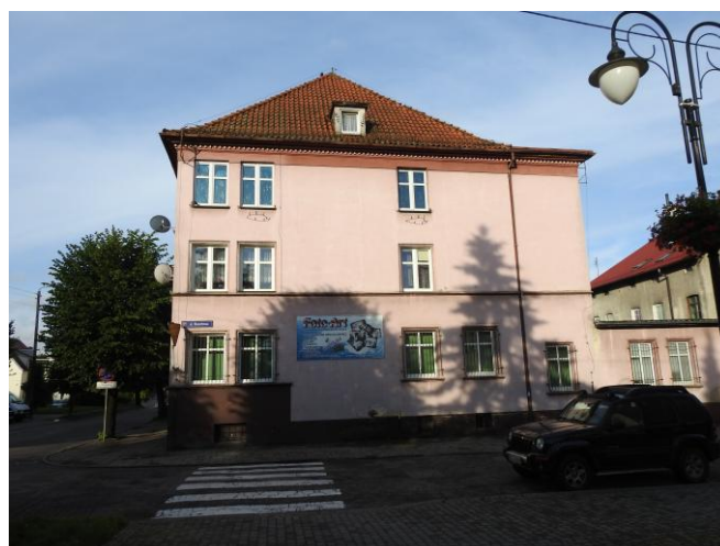
Fot. 3. Elewacja północno-wschodnia analizowanego budynku.
