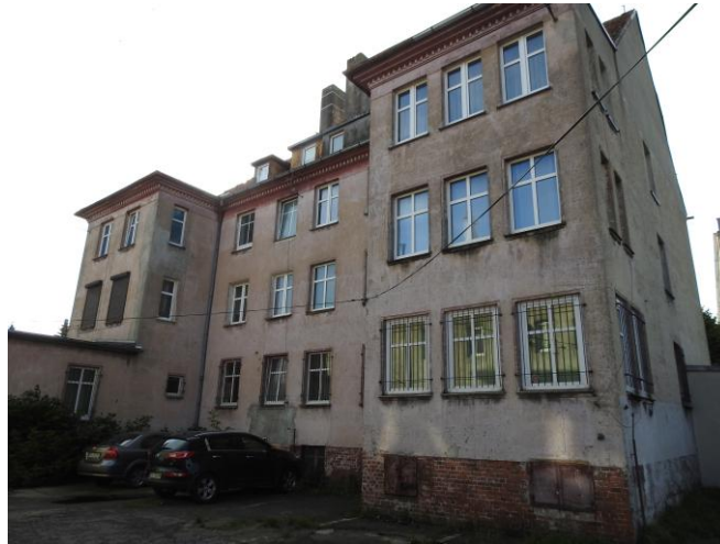
Fot. 5. Elewacja północno-zachodnia analizowanego budynku.
