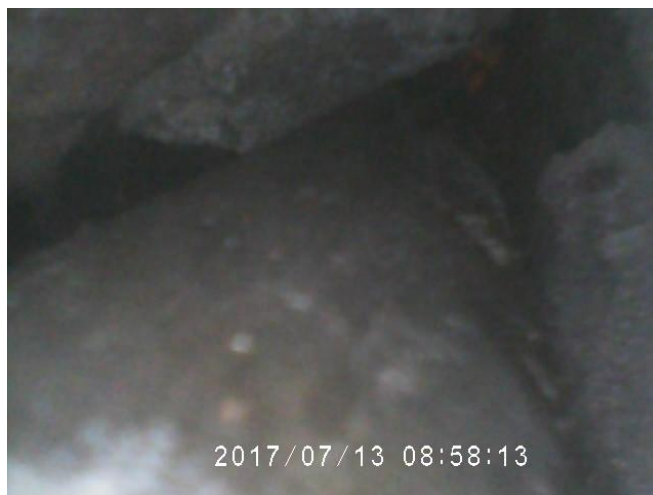
Fot. 23. Szczeliny w piwnicy sprawdzone za pomocą endoskopu-brak śladów bytowania nietoperzy.
