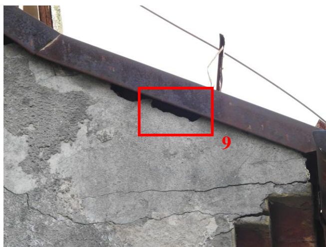
Fot. 17. Miejsce lęgowe wróbla w ubytku pod blachą dachową (kwadrat 9).
